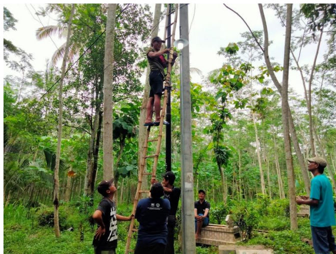
Gambar 8. Proses Pemasangan Lampu Penerangan Jalan
