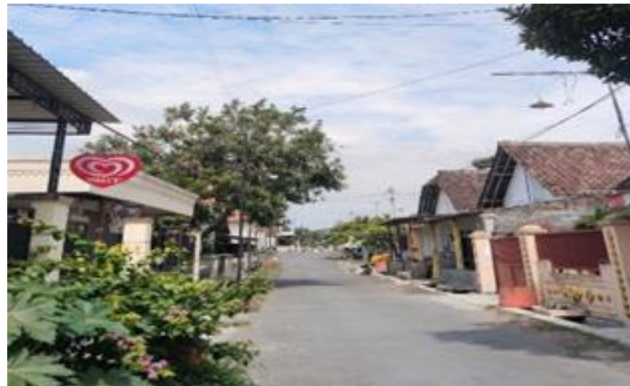
Gambar 4 Jalan di Desa Kebonsari
